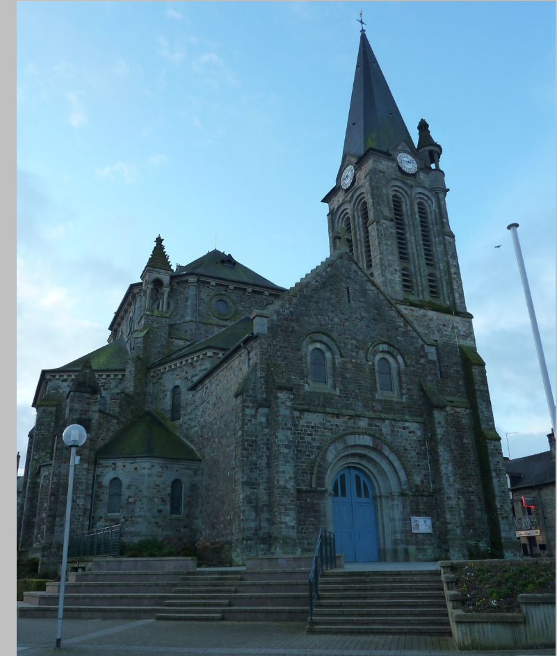
Eglise et son parvis - rue de Fougères
