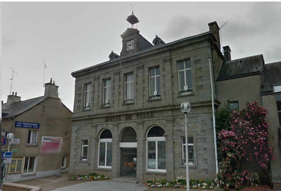
Mairie - rue de Fougères
