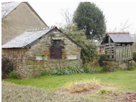
Ensemble four et puits au Landret
